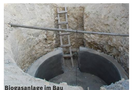
Biogasanlage im Bau
